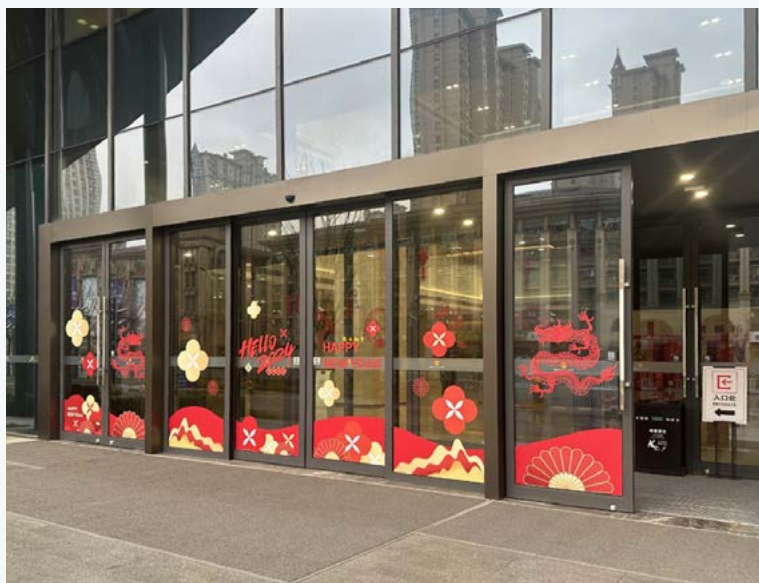
两侧配型材玻璃隔断
